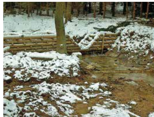
Dřevěná přehrážka z vytěženého materiálu, přírodě blízká alternativa zděných přehrážek v lesních povodích; dole schéma – příčný řez a půdorys.
