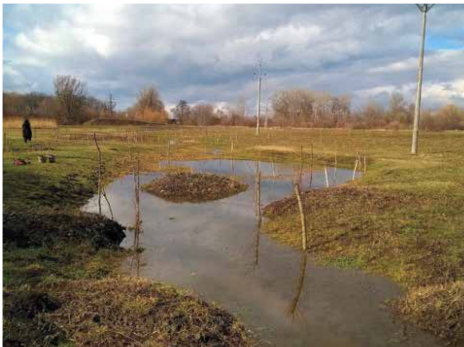
Revitalizace vodního toku tvorbou nového koryta, soutok Vřesůvky a Malého potoka v obci Čehovice na Prostějovsku (Foto Z. Poštulka).
